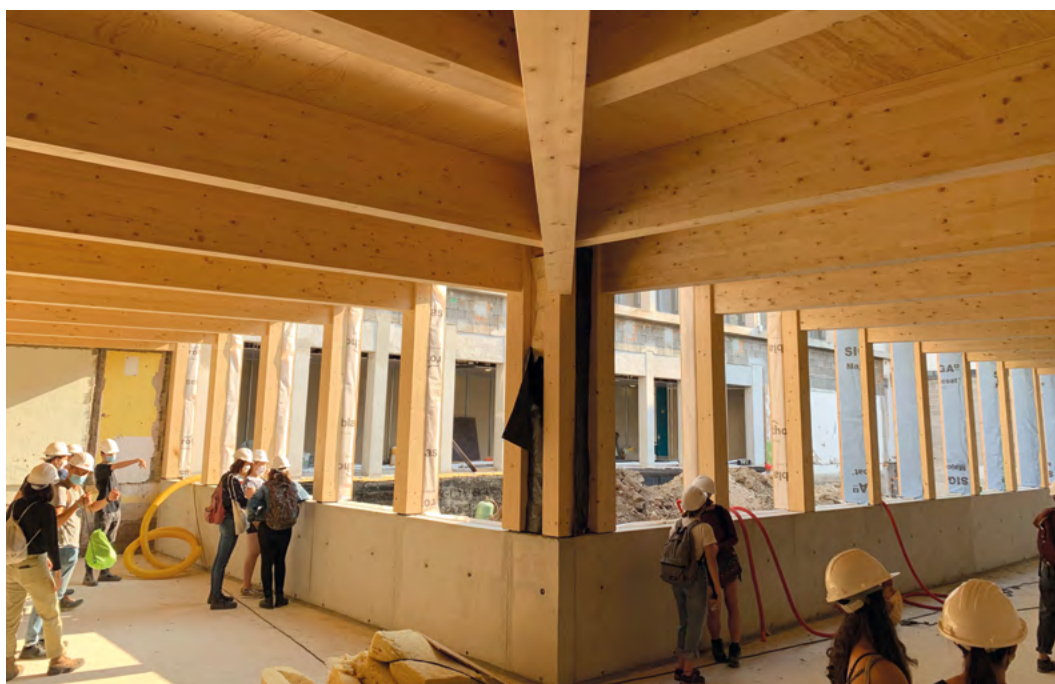
Visite de chantier
