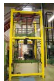
Sécurisation des presses (spécialité génie civil)
