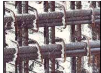
Figure 3 : Aperçu de points bruités à filtrer au niveau des liaisons entre les armatures
