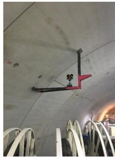
Figure 2 : Bracket supportant le prisme permettant l'orientation du TS15
