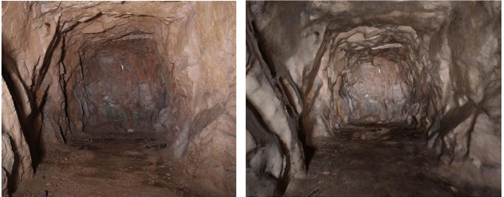
Figure 2 : Comparaison entre une photo (à gauche) du fond de la première galerie et sa modélisation (à droite)
