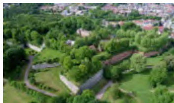
Fig. 1 : Vue aérienne actuelle de la citadelle de Doullens
