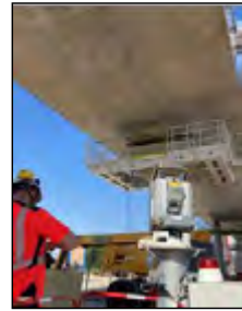
Fig. 4 : Installation du tachéomètre à proximité de la travée du pont
