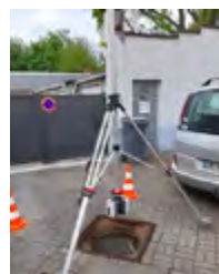
Figure 2 : Scanner Laser RTC360 sur trépied inversé
