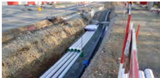
Fig. 2 : Une nappe électrique en cours de pose avec deux épaisseurs de quatre tubes à gauche ainsi qu'une conduite d'eau à droite
