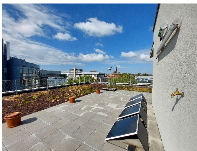
Zone d'expérimentation extérieure, station météo
