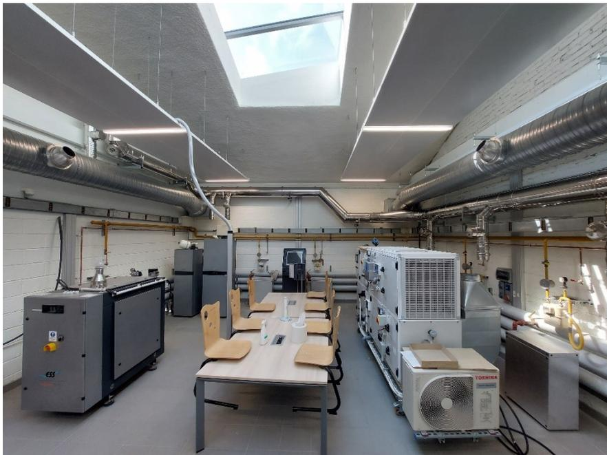
Pile à combustible, cogénération moteur, Régulation d'une centrale de traitement d'air
