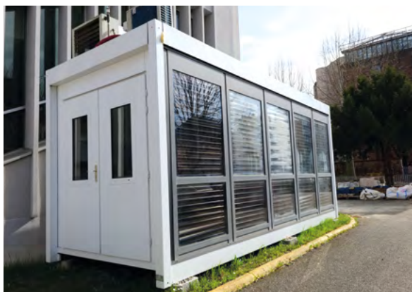
Algeco climatisation (plateforme génie électrique)
