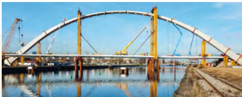
Construction du pont Citadelle à Strasbourg. Extension de la ligne D du tramway vers Kehl (Allemagne).
