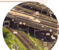
Transport: structures, infrastructures et mobilités
